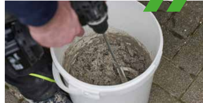
2 KÖSTER Betomor Multi A mit Wasser zu einer klumpenfreien, spachtelfähigen Masse anmischen.
